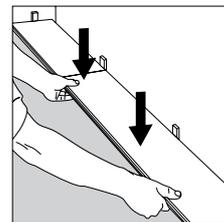
**À LA FIN DE LA RANGÉE** placez une lame à l'envers contre le mur afin de la couper à la longueur exacte, en prenant en compte le jeu de dilatation. Faites une marque à l'endroit où la lame doit être coupée et tracez la découpe avec une équerre. Si vous utilisez une scie manuelle ou une scie circulaire, coupez la lame face décor. Si vous utilisez une scie sauteuse électrique, mettez le décor vers le bas. Pour un résultat optimal, une scie circulaire à denture fine est l'outil idéal !
