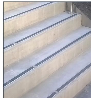
Adhésivé ADHEXT Test pendule SRT. Coefficient antidérapance 1,1 sol mouillé
